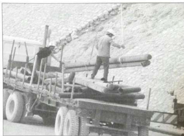
شکل ۲۷.۱۵ استقرار نا ایمن ریگر
