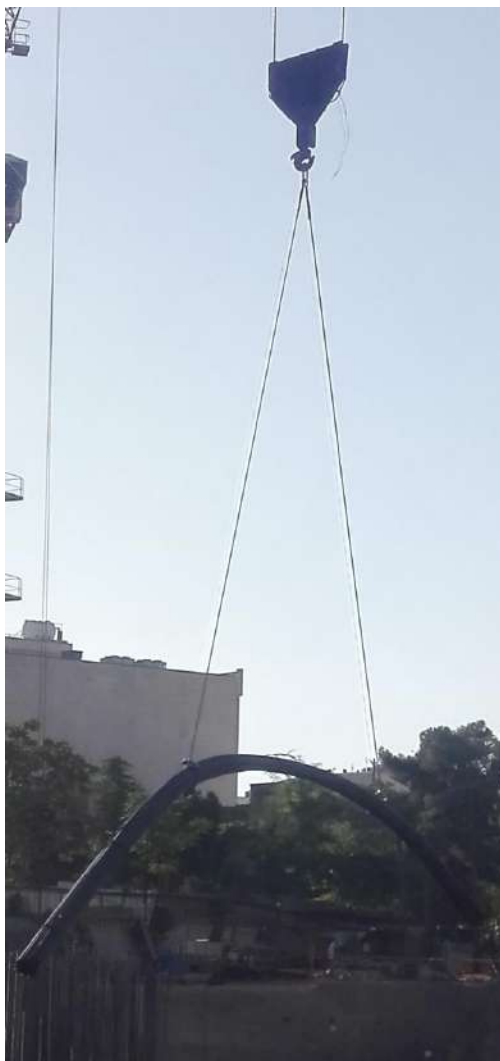
شکل ۲۶.۱۵ بلند کردن بار به صورت کج
