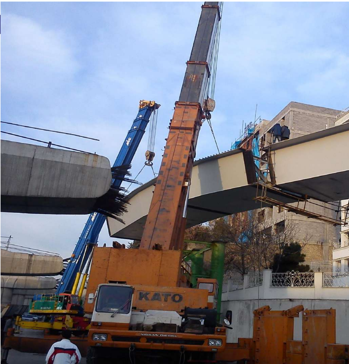
شکل ۴۰.۸ باز کردن کامل جک‌های تعادلی
