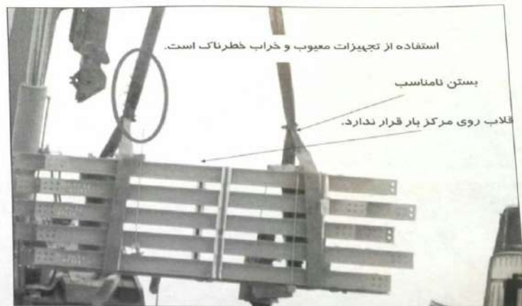
شکل ۲۶.۱۵ بلند کردن بار به صورت کج
